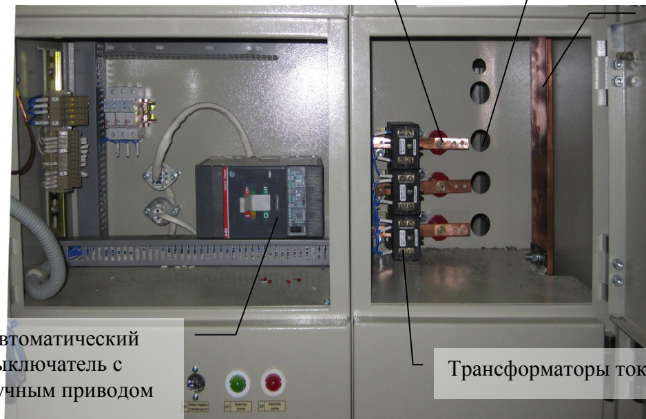
Рис. 10 Ячейка шкафа распределения при наличии расчетного учета электроэнергии.
