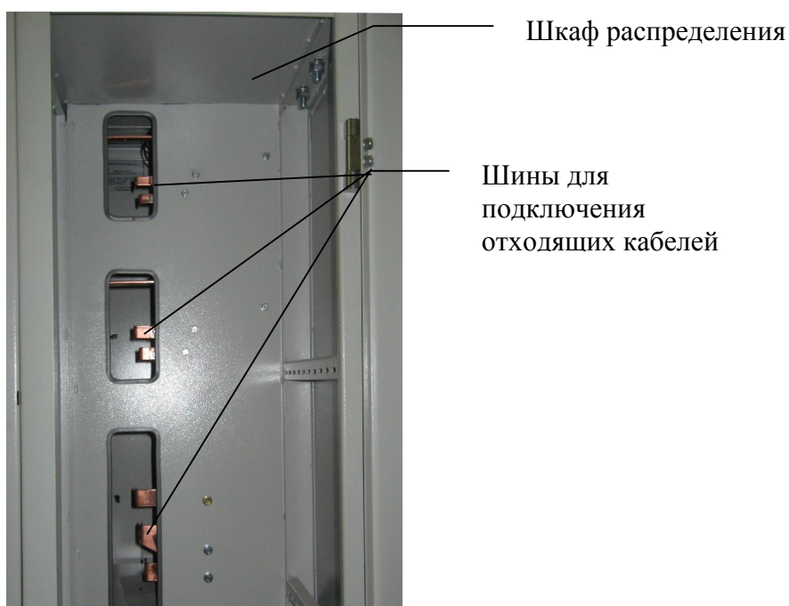
Рис. 9 Кабельный отсек (вид с задней стороны)
