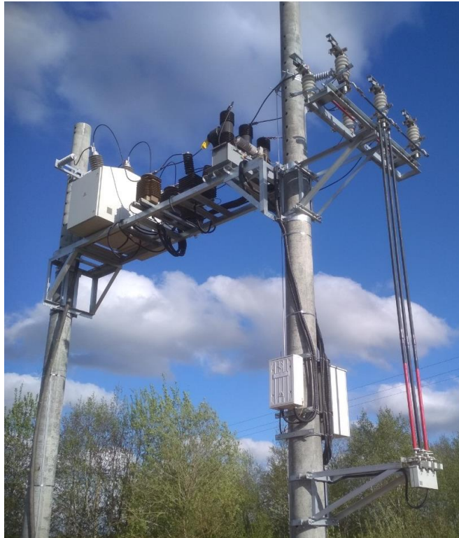
Рисунок А.1 – Внешний вид реклоузера вакуумного типа РВ-БЭМН (исполнение 35 кВ) на две опоры
