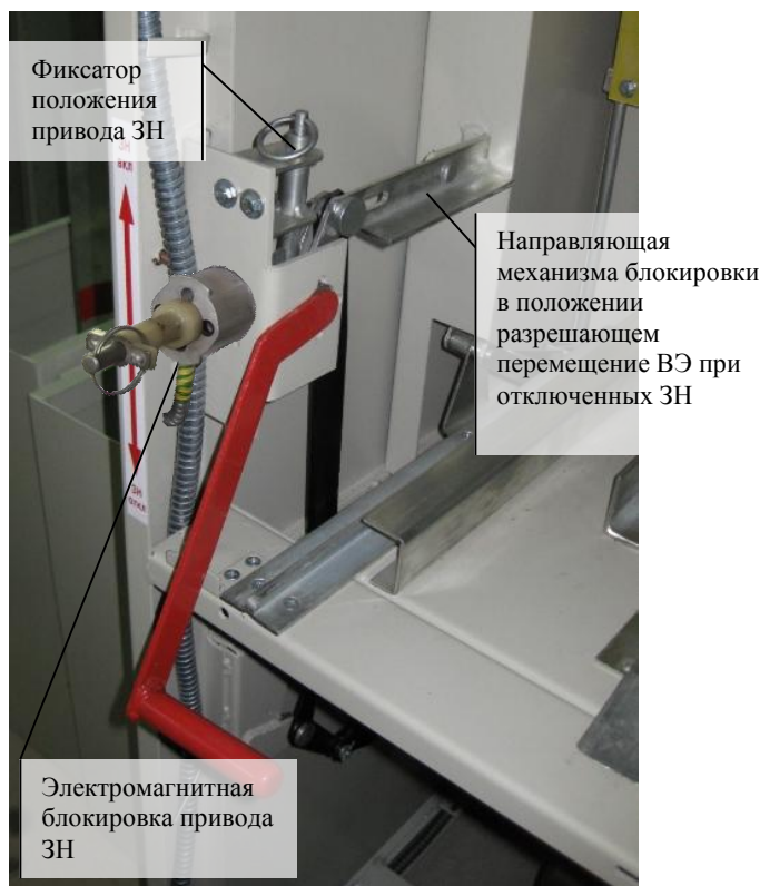
Рис.9. Блокировки ЗН и ВЭ. ЗН отключен.
