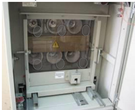
Рис. 27. Фазировочная тележка в отсеке ВЭ.
