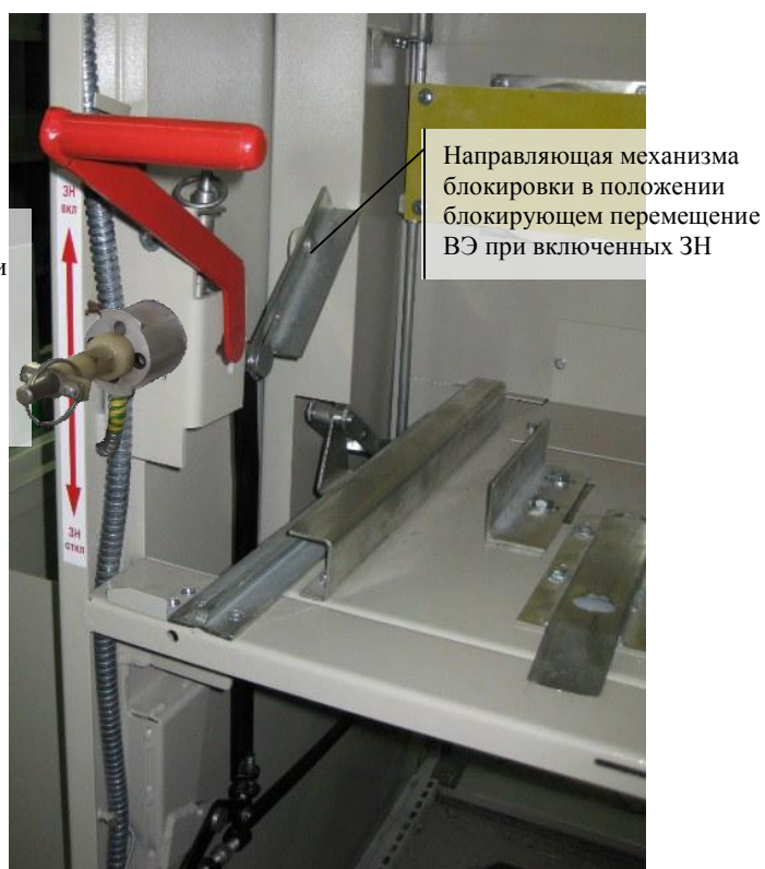
Рис.10. Блокировки ЗН и ВЭ. ЗН включен.
