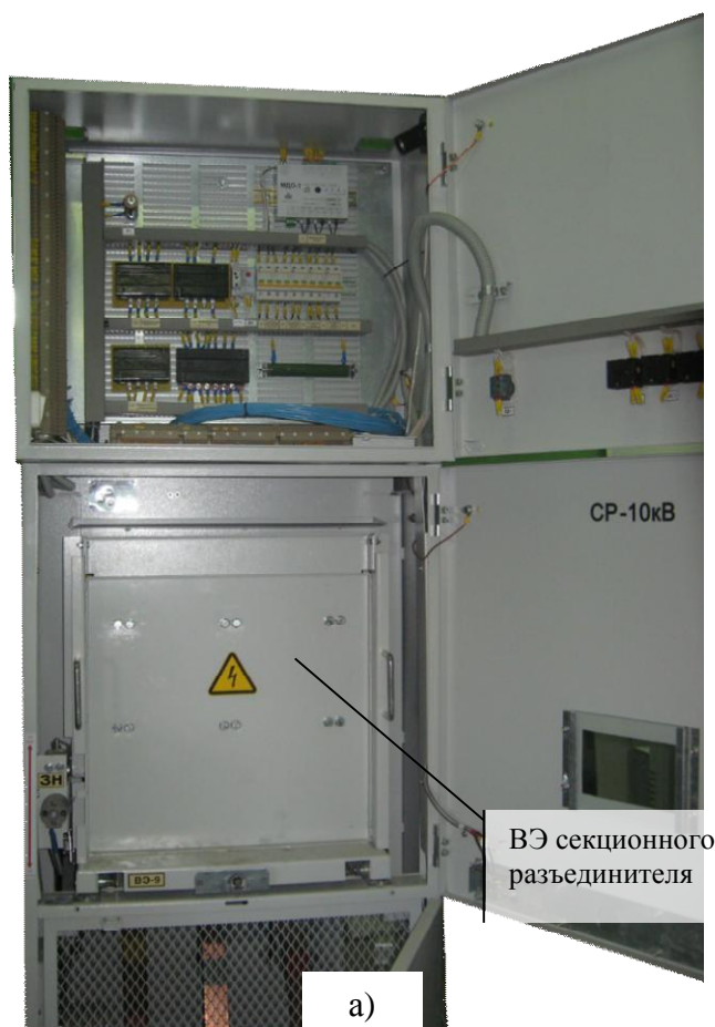
Рис. 19. а) Шкаф секционного разъединителя. б) Разъединитель на выкатном элементе.
