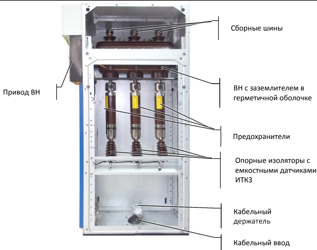
Рис.3 КРУЭ-БЭМН вид справа со снятой боковой панелью.
