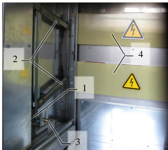
Рис. 9. Отсек ВЭ, блокировки, шторки.
