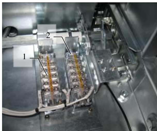
Рис. 19. Концевые выключатели ЗН.
