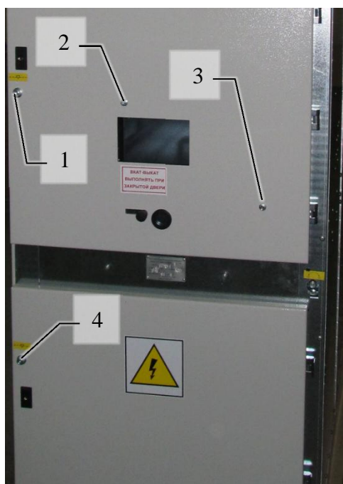
Рис. 10. Заглушки блокировочных отверстий отсеков ВЭ и КП.
