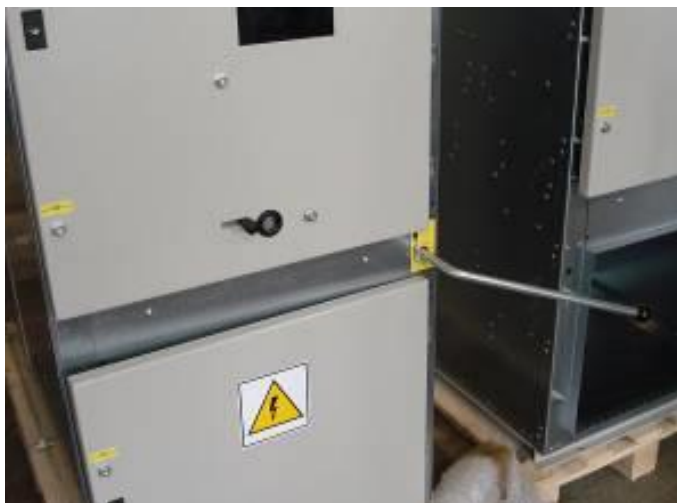
Рис. 17. Рычаг привода ЗН.
